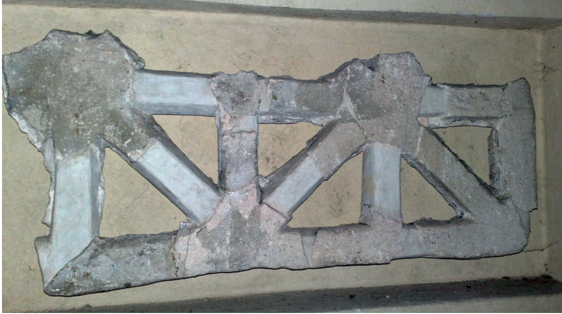
Fig. 8. Roma, chiesa di San Giorgio al Velabro, transenna di finestra in stucco e lapis specularis (foto S. Pannuzi).
