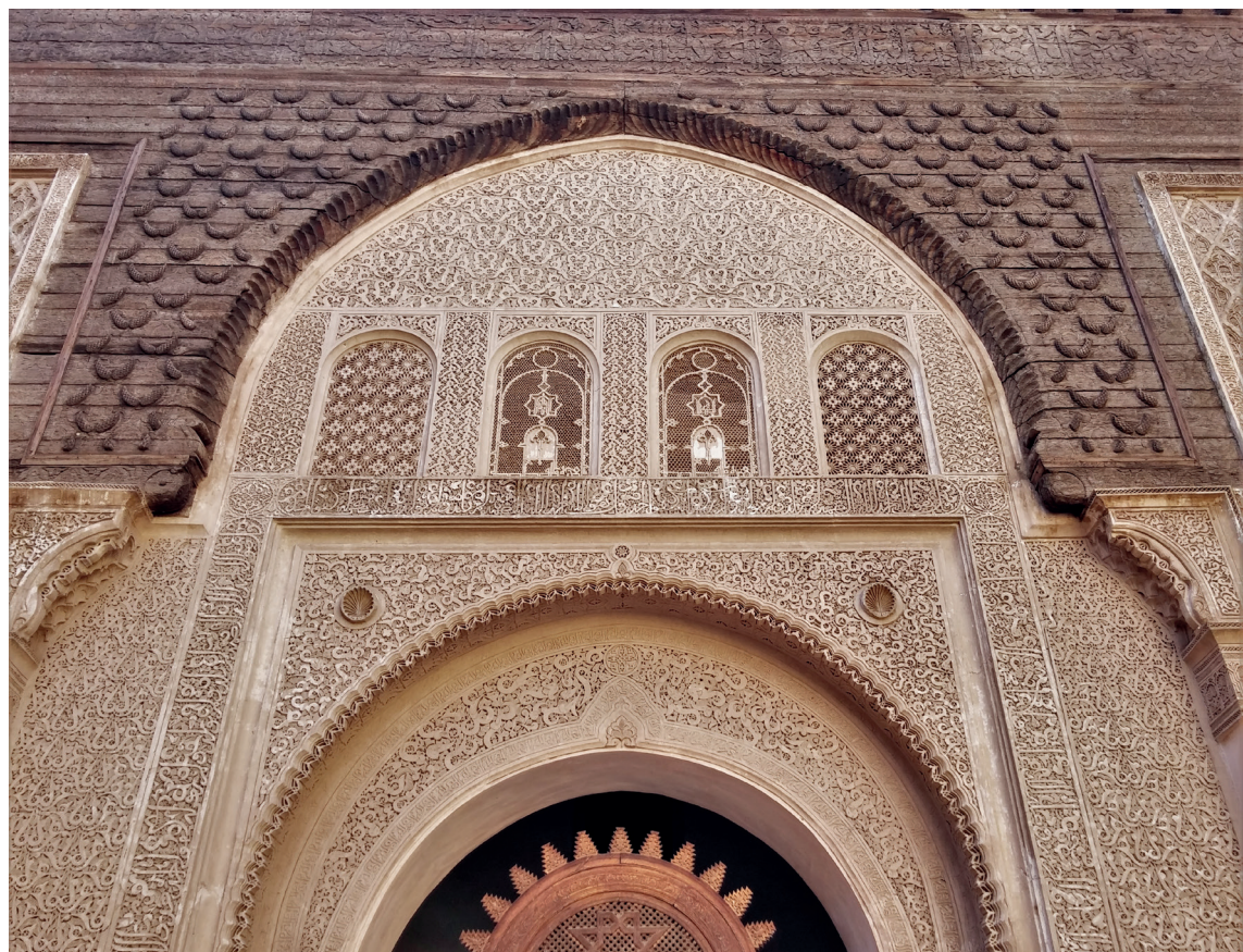
Fig. 7. Medersa Ben Youssef a Marrakech (Marocco). L'aspetto attuale della scuola coranica risale al XVI secolo e rappresenta uno dei più pregevoli esempi dell'uso decorativo dello stucco gessoso intagliato. Notare le quattro finestrelle ricavate da pannelli di gesso delicatamente traforati ( chemmassiat ). Il portale e gli elementi al di sopra dell'arco principale sono in legno di cedro finemente intagliato.
