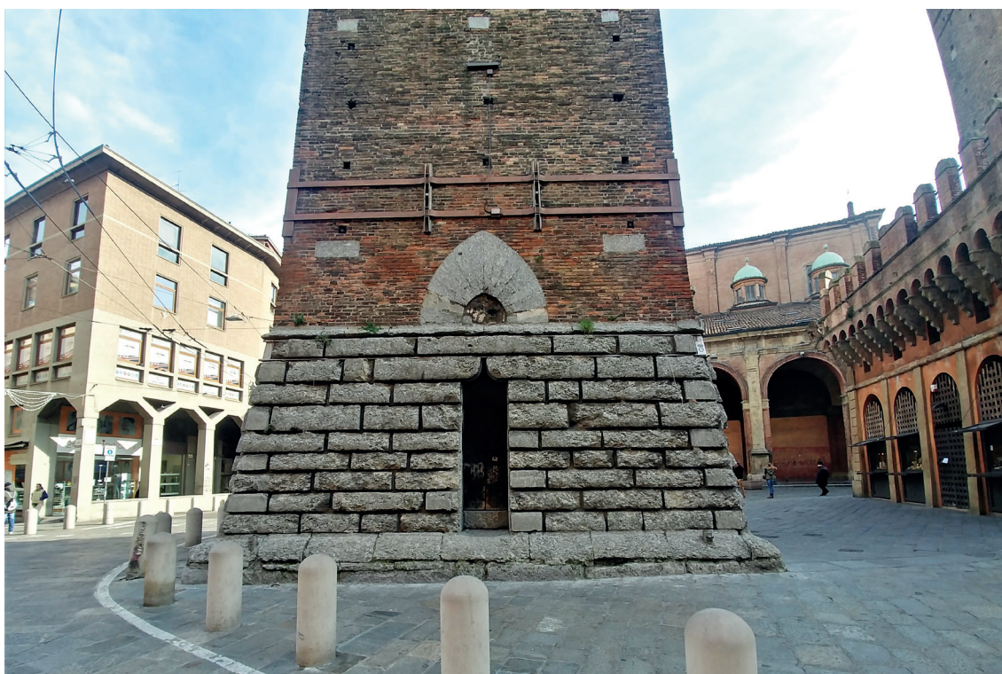
Fig. 4. Grandi blocchi di selenite a rivestimento del basamento della torre Garisenda a Bologna. Costruita ai primi del 1100, la torre superava i 60 metri di altezza ma fu mozzata a 48 metri verso il 1360 a causa della forte inclinazione raggiunta per cedimento del terreno di fondazione. Un rivestimento in blocchi di gesso è presente anche al di sotto del loggiato della torre degli Asinelli (a destra), costruita nello stesso periodo.
