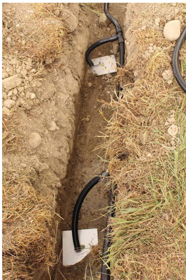
Fig. 1 - Cavi, ricoperti da una guaina anti roditore ed equipaggiati con elettrodi a piastra, allocati in trincea
