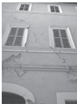
FIGURA 9.8 Lesioni da taglio con fessurazione diagonale
