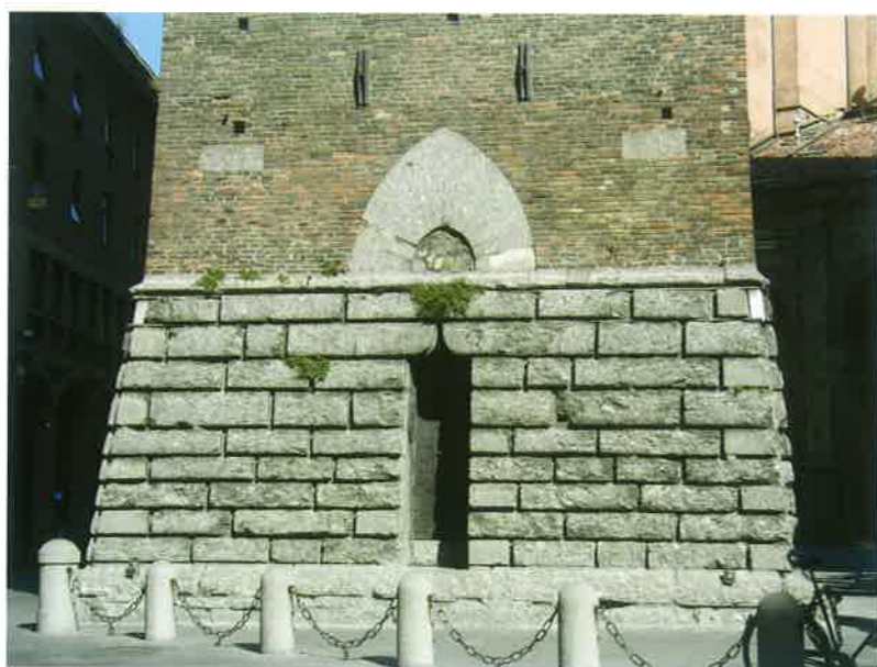
Blocchi di selenite messiniana rivestono il basamento della torre medioevale della Garisenda a Bologna
