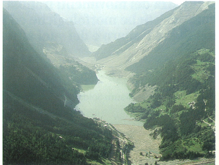
Fig. 2 - Frana di P.zo Coppetto e relativo lago di sbarramento sul F. Adda (Valtellina, agosto 1987) (foto Pasuto).
