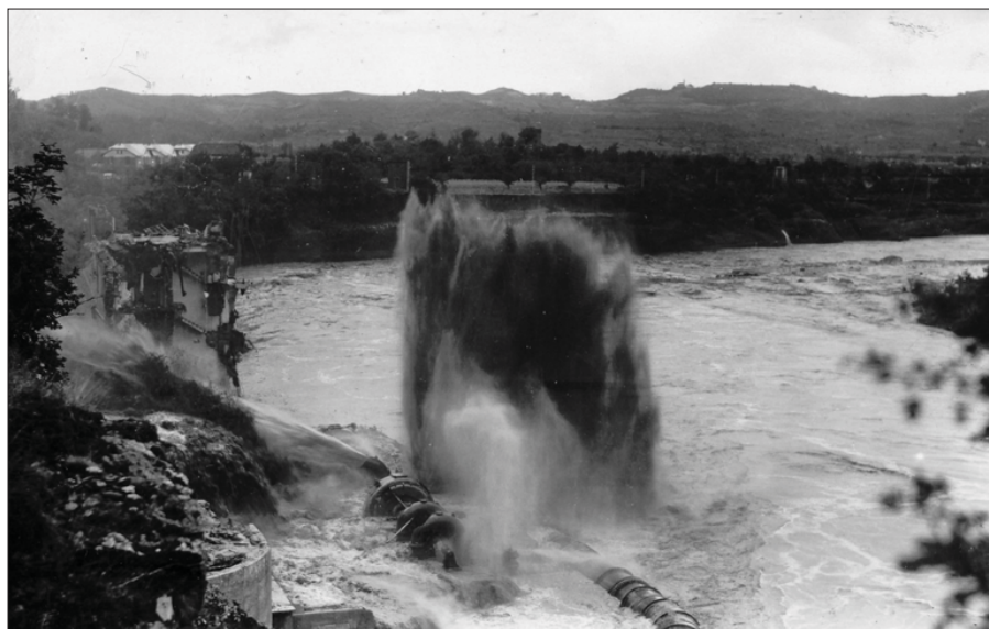
Figura 5 - La completa distruzione della centrale elettrica mentre la condotta forzata si sta svuotando.
