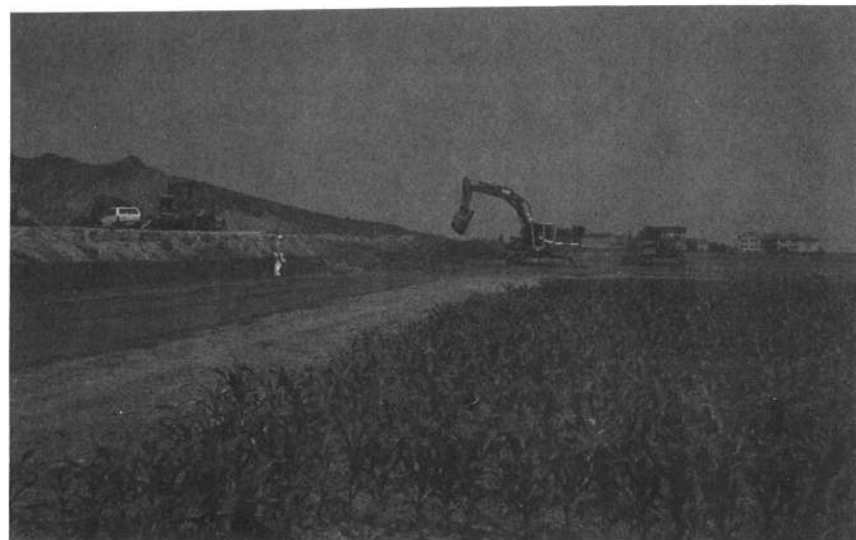
Foto 3.3 — Località C. Madonna del Fiasca: panoramica dell'attività estrattiva in corrispondenza del dosso di Valbissara. In primo piano si nota come l'area precedentemente spianata sia stata restituita all'uso agricolo (Luglio 1991).
