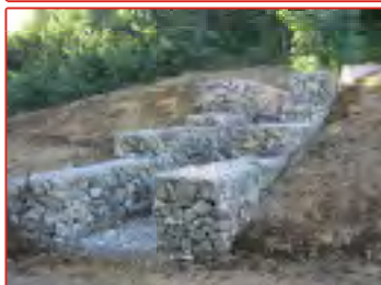
Opere di sostegno a gravità
