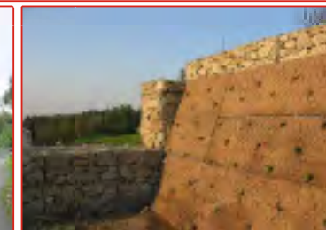
Opera di sostegno : Terramesh
