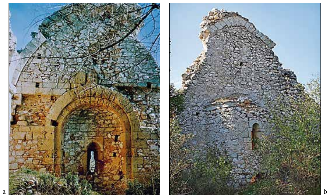
Fig. 2. - Chiesa di Sant'Egidio in pantano. A. veduta absidale; B. esterno dell'abside (foto G. Massimo).
